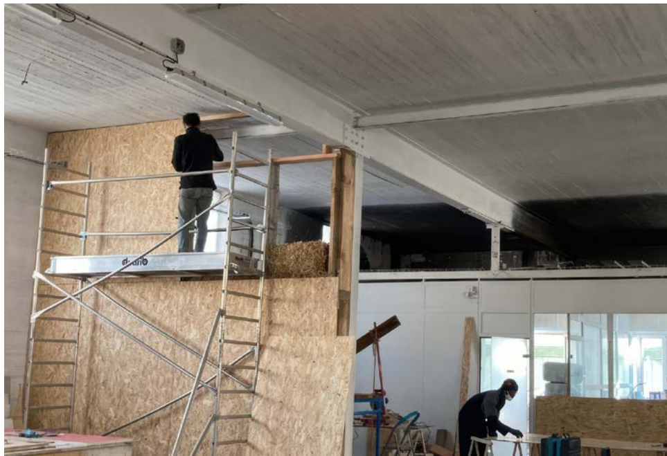
➤ Cloison séparative de l'atelier mutualisé à Romainville (bois récupéré, paille bio, enduit à base de terre récupérée)
