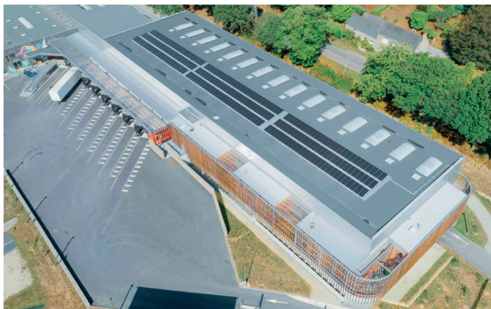
➤ La centrale photovoltaïque
