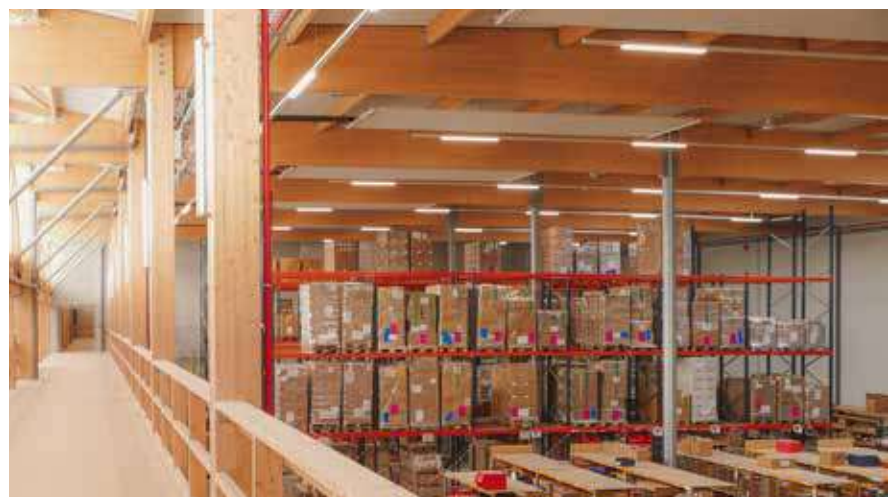
↗ L'entrepôt d'Écodis 4 depuis la passerelle
