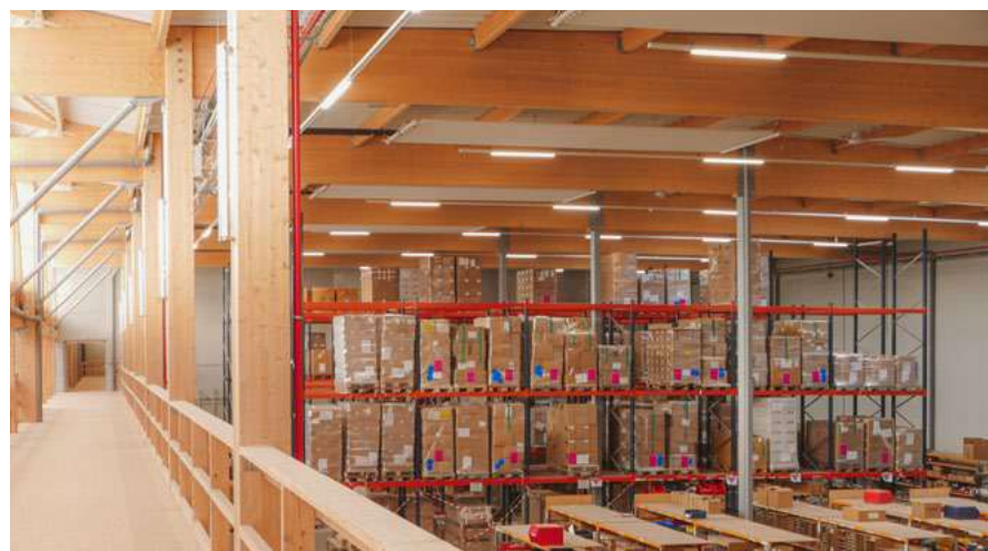
↗ L'entrepôt d'Écodis 4 depuis la passerelle
