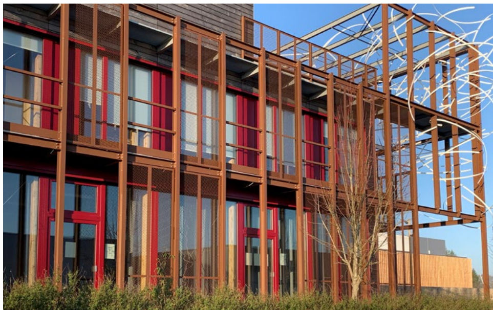
➤ Écodis 3, nouveau bâtiment passif de bureaux en bois de pays
